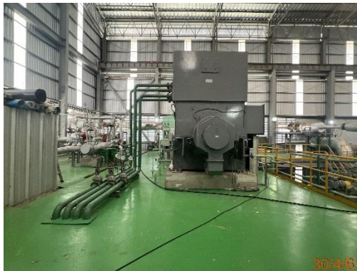
รูปที่ 47 ฐานวางเครื่องกำเนิดไฟฟ้า
